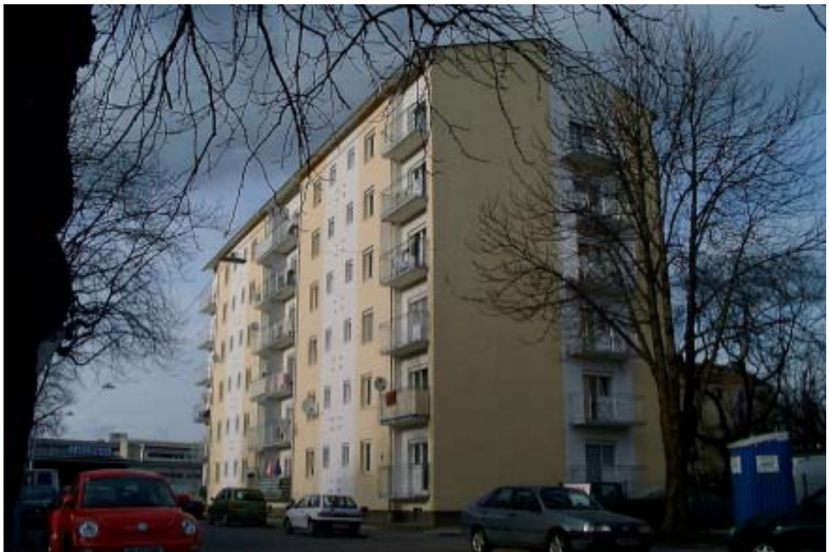
Abbildung 7: Wohnhausanlage Asperngasse/Daugasse vor und nach der Sanierung
